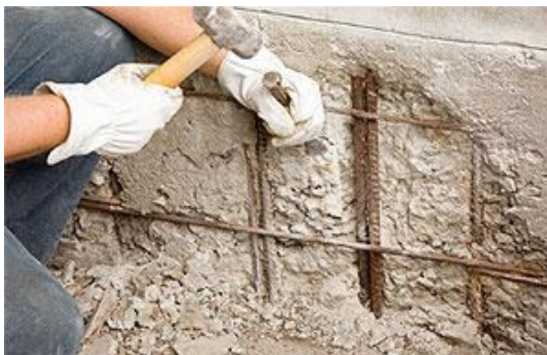
Figura 2 - Reparo de uma não conformidade após concretagem de uma viga baldrame
