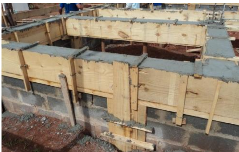
Figura 1- Ilustração de uma concretagem de viga baldrame
